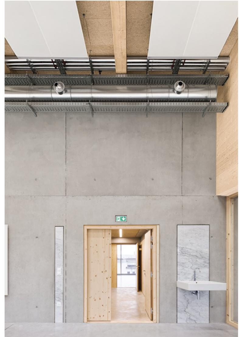
La structure secondaire y converge. Les réseaux aussi, distribués longitudinalement. Les paliers sont traversants pour faciliter l'orientation des élèves.
