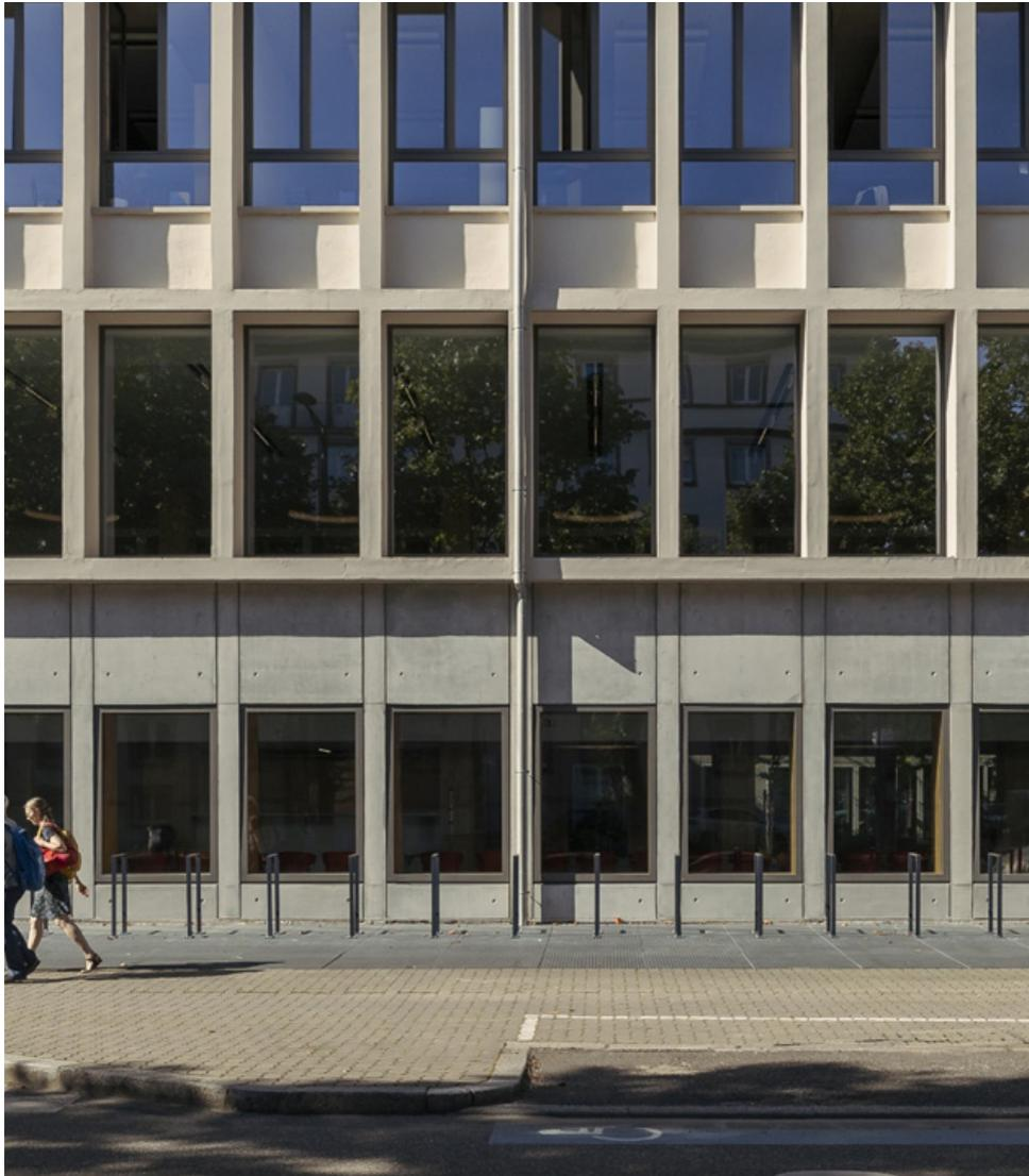
En reprise du socle, pas d'effet superflu : les assemblages de béton brut s'affichent, la gouttière file droit. Les menuiseries à bascule des étages sont remplacées par des ouvrants à la française, plus performants mais aussi plus manipulables et simples d'entretien. Leur coloris sombre se fond dans le vitrage et souligne les éléments structurels aux teintes claires.
