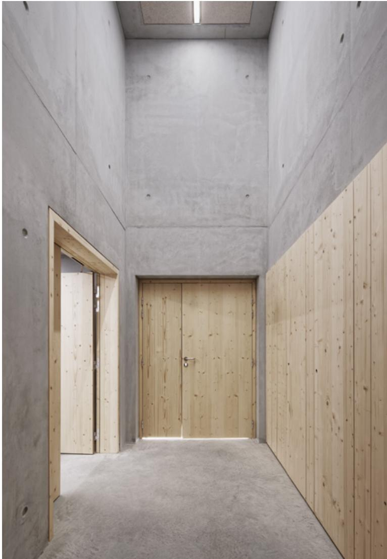
Le noyau concentre réponses techniques et d'usages. Le béton, nécessaire pour reprendre l'ensemble des efforts du bâtiment, répondre aux contraintes de sismicité et de sécurité incendie, est assumé.
