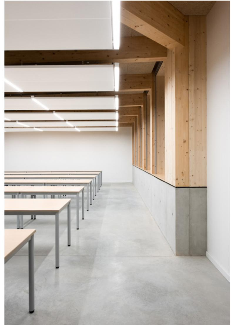
Le bon matériau au bon endroit : dans les salles autour du patio, le béton règne en structure sous le niveau du sol, au dessus le bois prend le relais.
