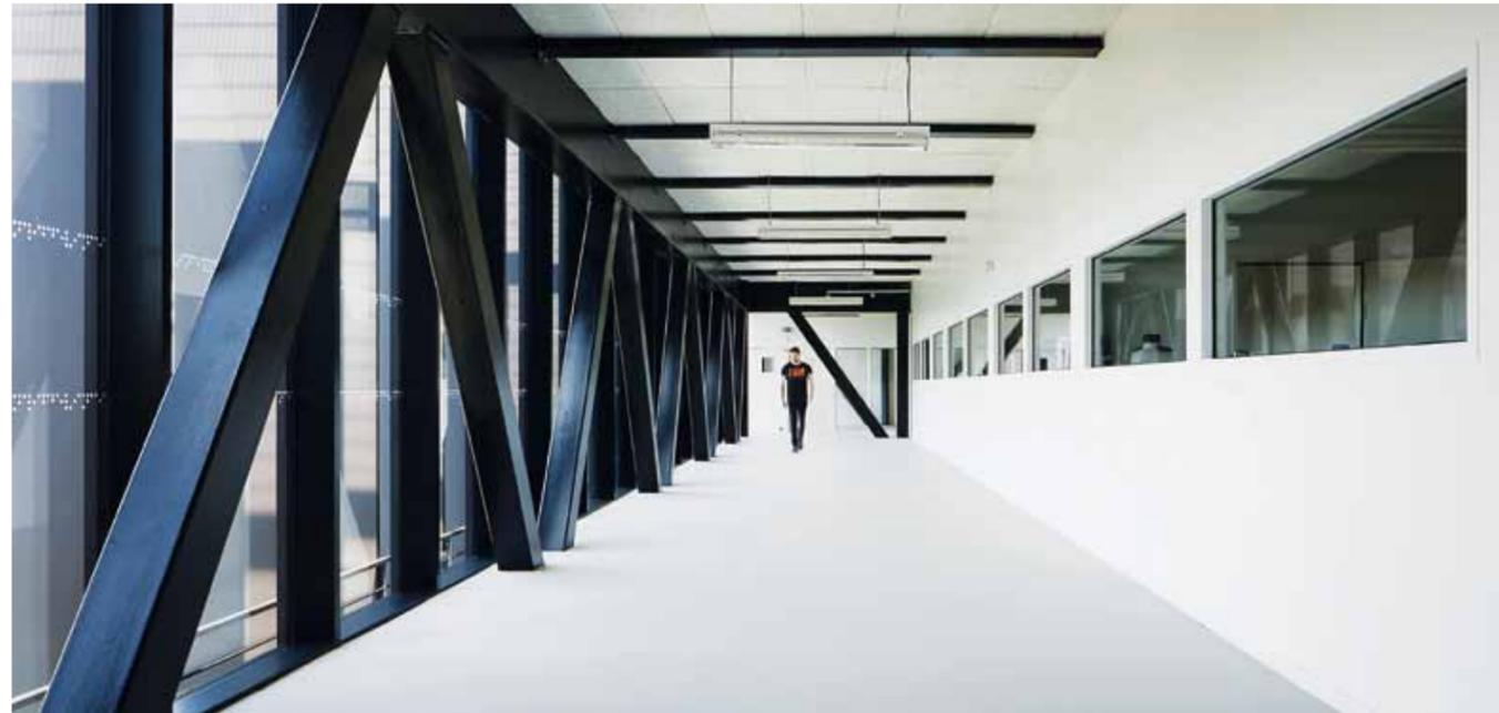
Composée tantôt de portiques, tantôt de poutres à treillis, comme dans cette circulation, la structure est la matière même du bâtiment.
