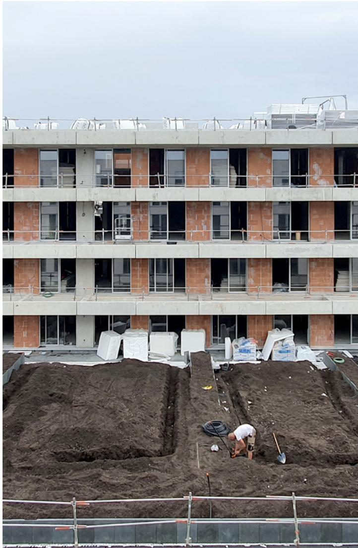
Les logements en attique émergent d'un jardin suspendu au dessus du parking. La brique creuse, légère, prend le relais des poteaux de béton dans les interstices de la structure.
